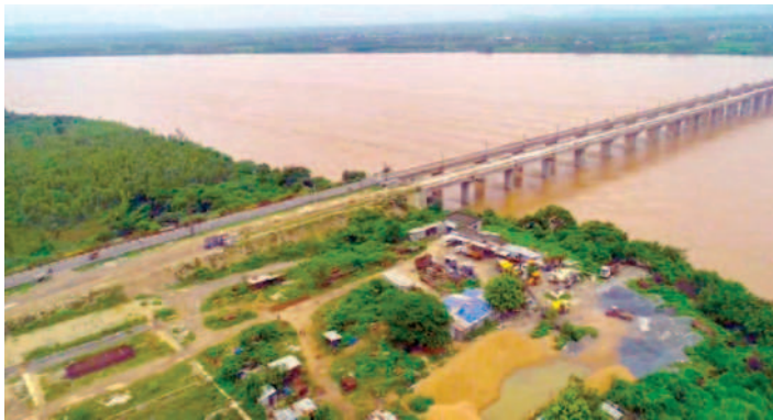
భద్రాచలం వద్ద పెరిగిన గోదావరి నీటి మట్టం
